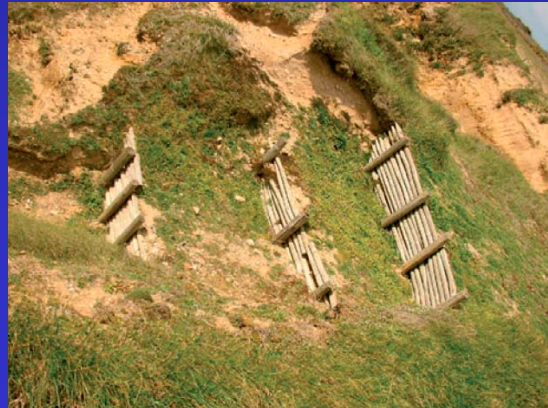
Maîtrise de l'érosion
