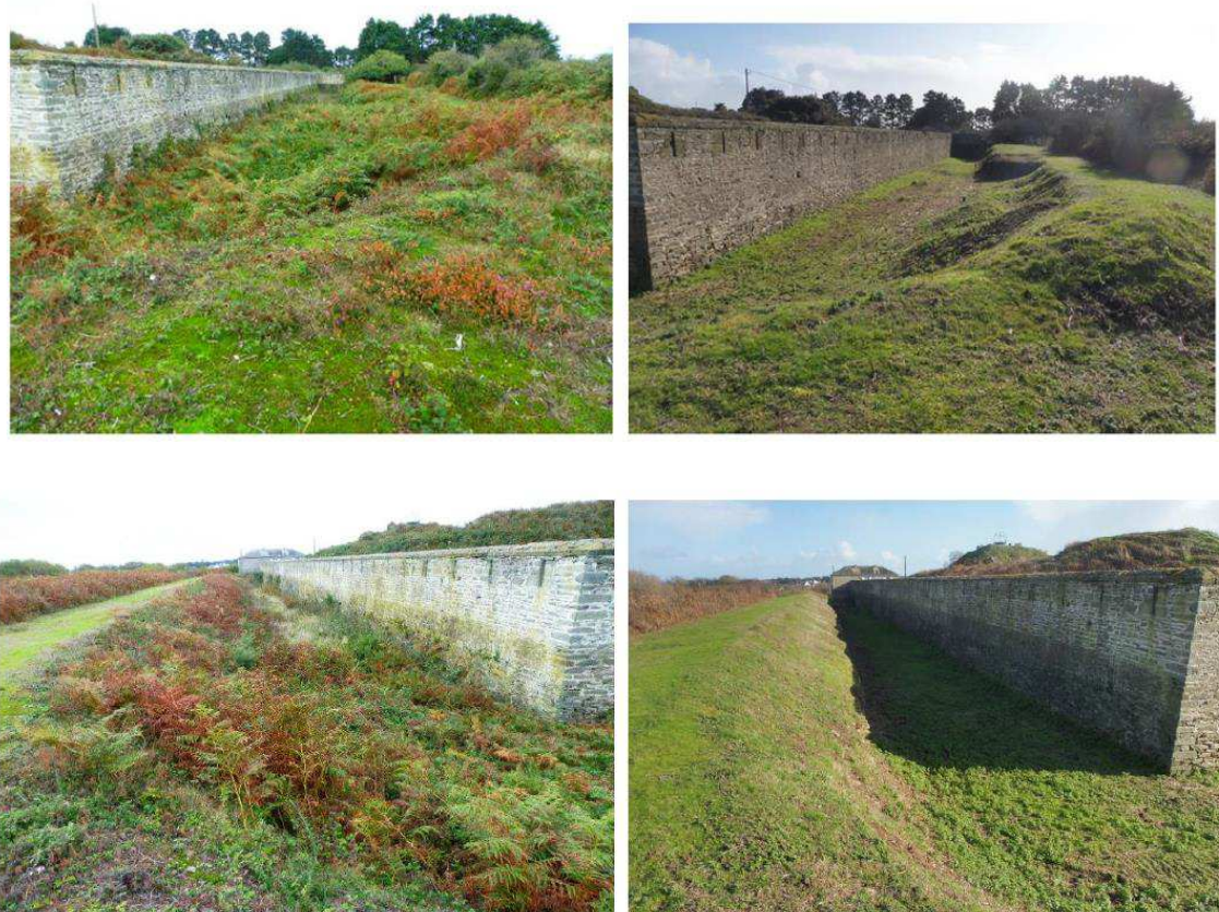
Entretien des douves du Haut-Grognon (de gauche à droite : photos avant-après)
