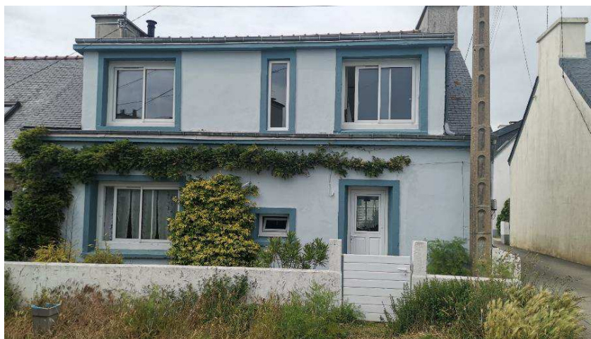
nouveau local à Créhal
