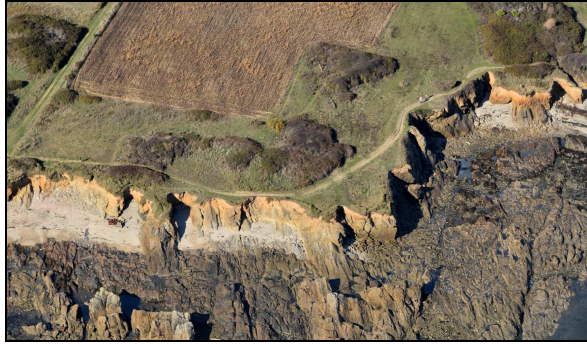
La maîtrise de l'érosion côtière entre Locmaria et la Pointe des Chats (recul du sentier côtier)
